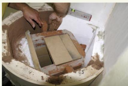
Der Verbrennungsraum der KRONA Kachelöfen wurde so optimiert, dass am Ende des langanhaltenden Verbrennungsvorgangs nur wenig Asche übrig bleibt. Denn durch die optimalen Temperaturen in der Brennkammer wird die üblicherweise entstehende Holzkohle fast vollständig zu Kohlenstoffoxiden verbrannt. Deswegen müssen KRONA Kachelöfen deutlich seltener gereinigt werden als herkömmliche Kaminöfen.
