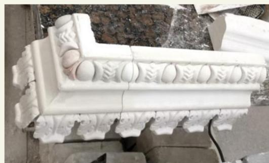
*Eine neue Krone nach originaler historischer Vorlage wird von dem Modeller Veiko Minge gefertigt. Viel präziser als das Original und schärfer im Relief. Jede Form für Reimann's KRONA entsteht als komplette Neufertigung und nicht als einfacher Abdruck einer alten Form*
