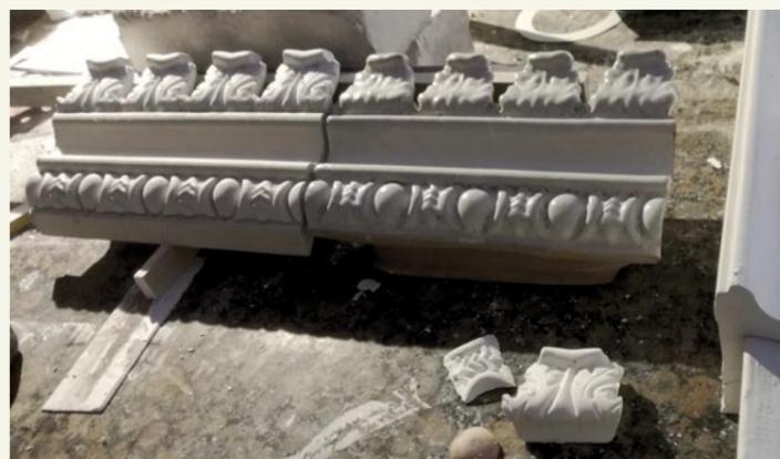
*Vergleich von Originalteil und neu gefertigtem Modell*
