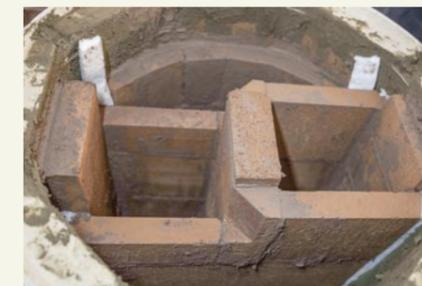
*Das Innenleben eines Grundofens ist echte Handwerkskunst. Dank der Brennkammer und des keramischen Zugsystems wird die im Brennstoff Holz enthaltene Heizenergie optimal genutzt*
